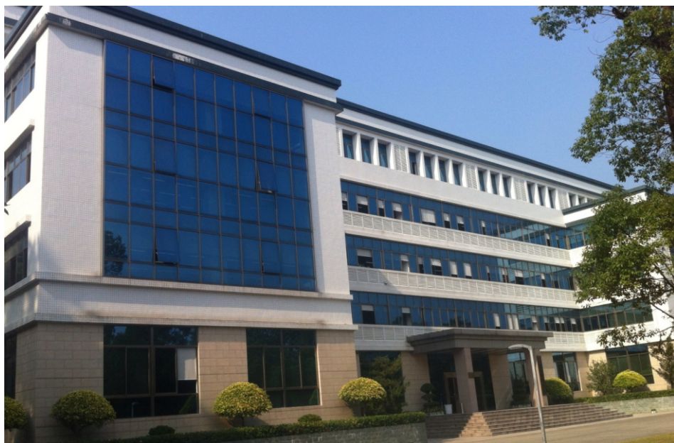
• Контактный центр для клиентов Guangdong Unicom
